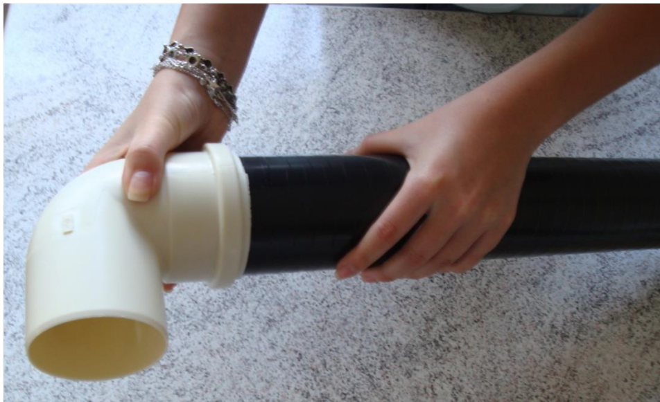
Figura 6. Encaixar os “cotovelos” no cano de PVC.
