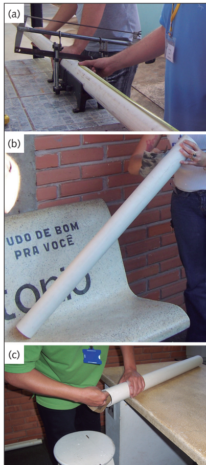
Figura 4.10 Corte, limpeza e preparação dos tubos de PVC, em (a), (b) e (c).
