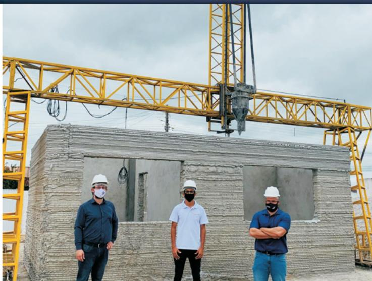
Imagem 3: Impressora 3D e uma casa sendo construída.
