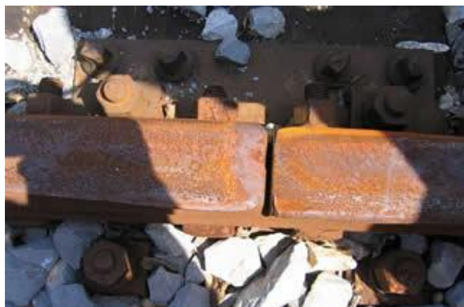
Imagem 1: Espaçamento entre os trilhos. Fonte:
